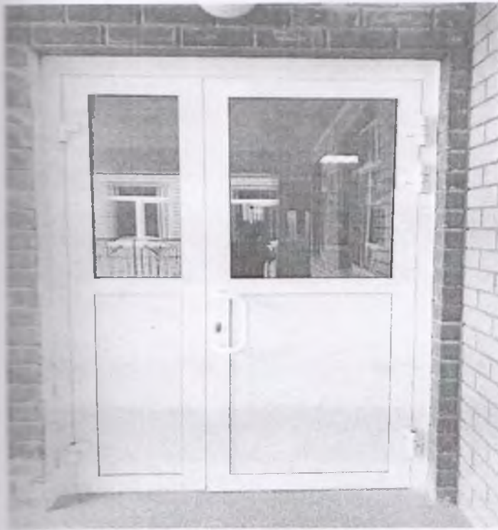
входная дверь (центральная)
